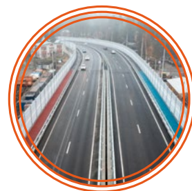
Строительство транспортной развязки во Всеволожском районе. Объект вошел в ТОП-5 национального проекта «Безопасные качественные дороги»
