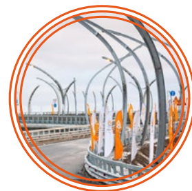
Строительство развязки ЗСД в районе Шкиперского протока
