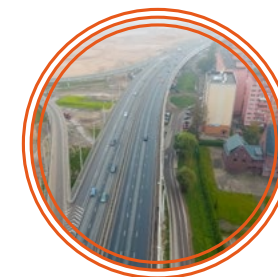
Строительство съездов с мостового перехода через реки Старая и Новая Преголя и транспортной развязки в районе бульвара Солнечный в Калининграде
