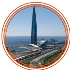
Строительство улиц, окаймляющих квартал «Лахта Центр», и примыканий к Приморскому шоссе, а также строительство эстакадных съездов
