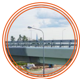
Строительство примыкания к транспортной развязке КАД автодороги к объекту «Аэропортовый комплекс на аэродроме Левашово»
